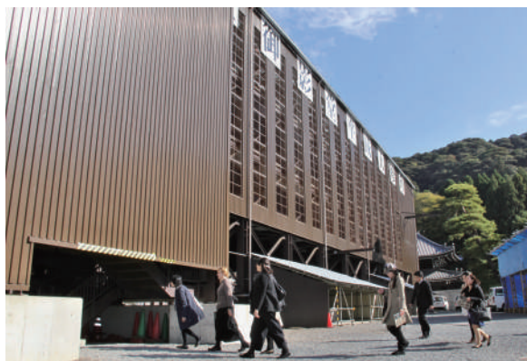
知恩院御影堂修理現場
