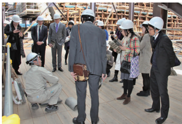
知恩院御影堂修理現場
